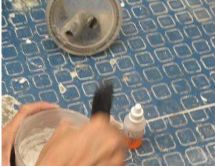
Ilustración 162. Mezclado manual de yeso.
